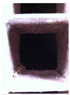
圖 2-9、圓筒倉上方開口之防跌鐵柵蓋附滿玉米碎屑易吸取空氣中水
