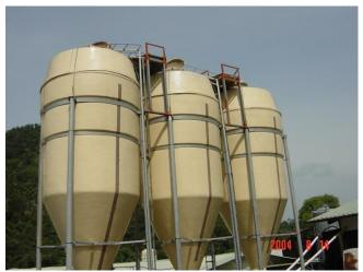
圖 2-75、晴天時應將散裝筒頂蓋打開使筒內水氣逸散。
