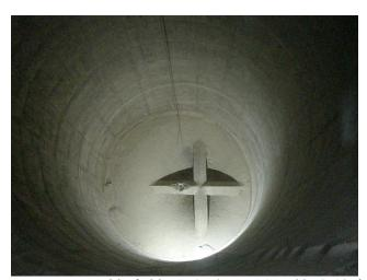
圖 2-11、圓筒倉筒壁與底部所附著或積存玉米碎屑易吸取空氣中水份 而致發霉:圖中十字形物為倉底中心運卸系統的保護蓋。
