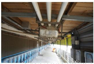
圖 2-82、自動餵飼系統的飼料輸送管線應定時以含黴菌抑制劑 之飼料沖刷清理以避免殘留在管線內之飼料發霉。
