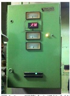
圖 2-5、 圓筒倉之溫控系統螢幕顯示倉內穀物之溫度。
