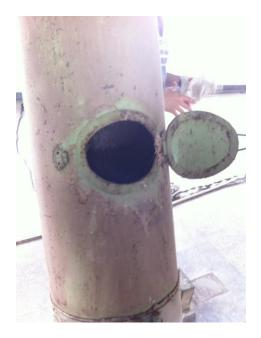
圖 2-23、輸送玉米之管線開口。
