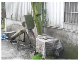
圖 2-56、自配戶室外的大宗散裝原料之入口:缺失為無遮雨棚,僅以 帆布覆蓋。
