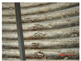
圖 2-77、散裝飼料筒內壁凹痕處極易積存飼料而發霉 成為後續飼料的黴菌接種源。
